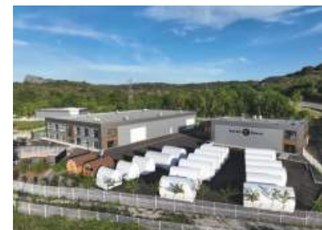
Locaux de Nordic House à Saint-Martin-de-Londres
