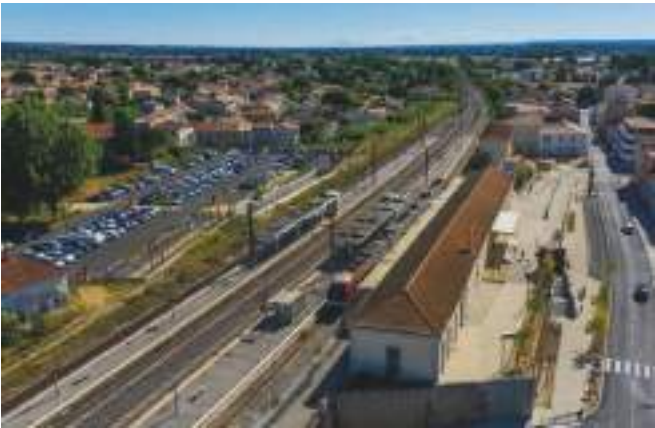
Pôle d'échange multimodal ©Pays de Lunel
