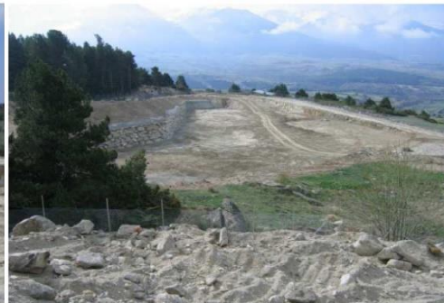
Les travaux de terrassement pour les premiers bâtiments
