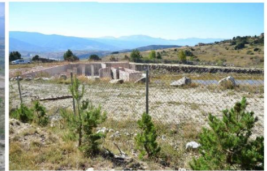
Travaux de fondations d'un bâtiment envisagé sur la partie sud du site
