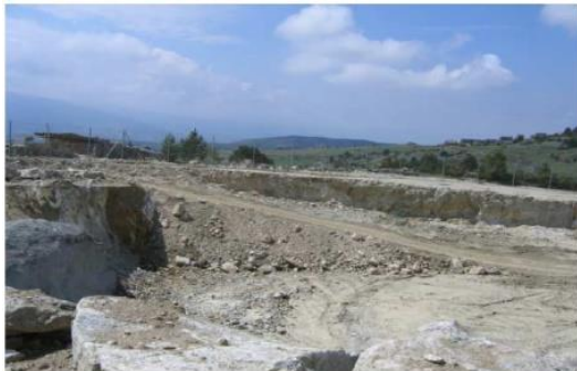
Pré-terrassements des voies réalisés
