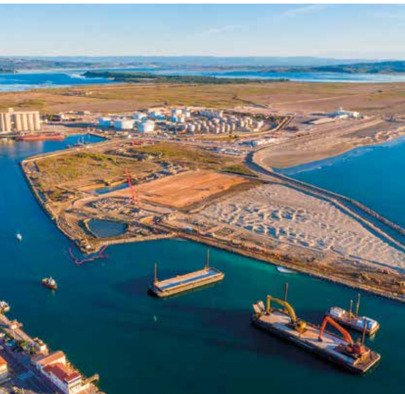
Port-la-Nouvelle, futur hub de l'éolien flottant en Méditerranée. © L.Lecarpentier
